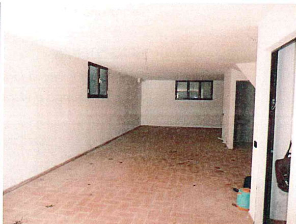
Foto 29 = garage con fondo (vista da ingresso)
