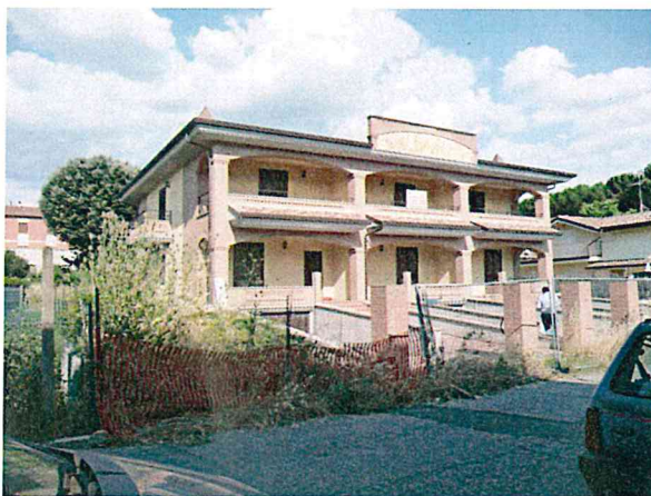
Foto 2 = fronte strada e lato nord
