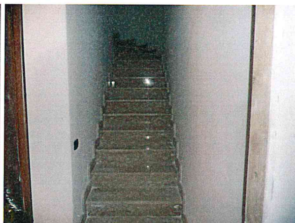
Foto 31 = vano scala da p.sottostrada a p.t.
