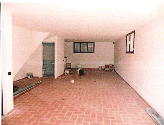
Foto 72 = garage con fondo (vista da ingresso)
