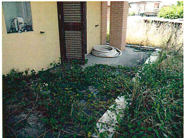
Foto 11 = marciapiede portico retro (lotto 1)
