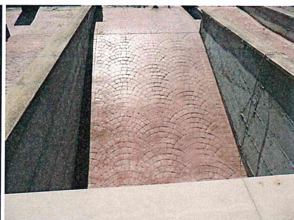
Foto 39 = rampa accesso garage
