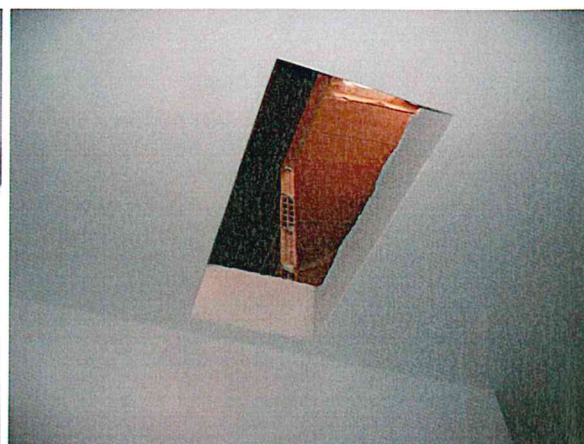
Foto 62 = botola accesso soffitta non praticabile
