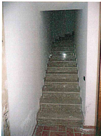
Foto 74 = vano scala da p.sottotrada a p.t.
